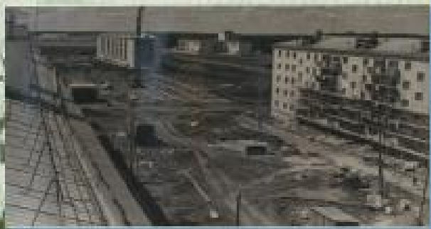
Строительство пятиэтажных домов и Дома техники нефтяников
