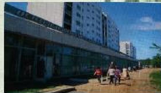
Торговый ряд улицы в районе городского парка
